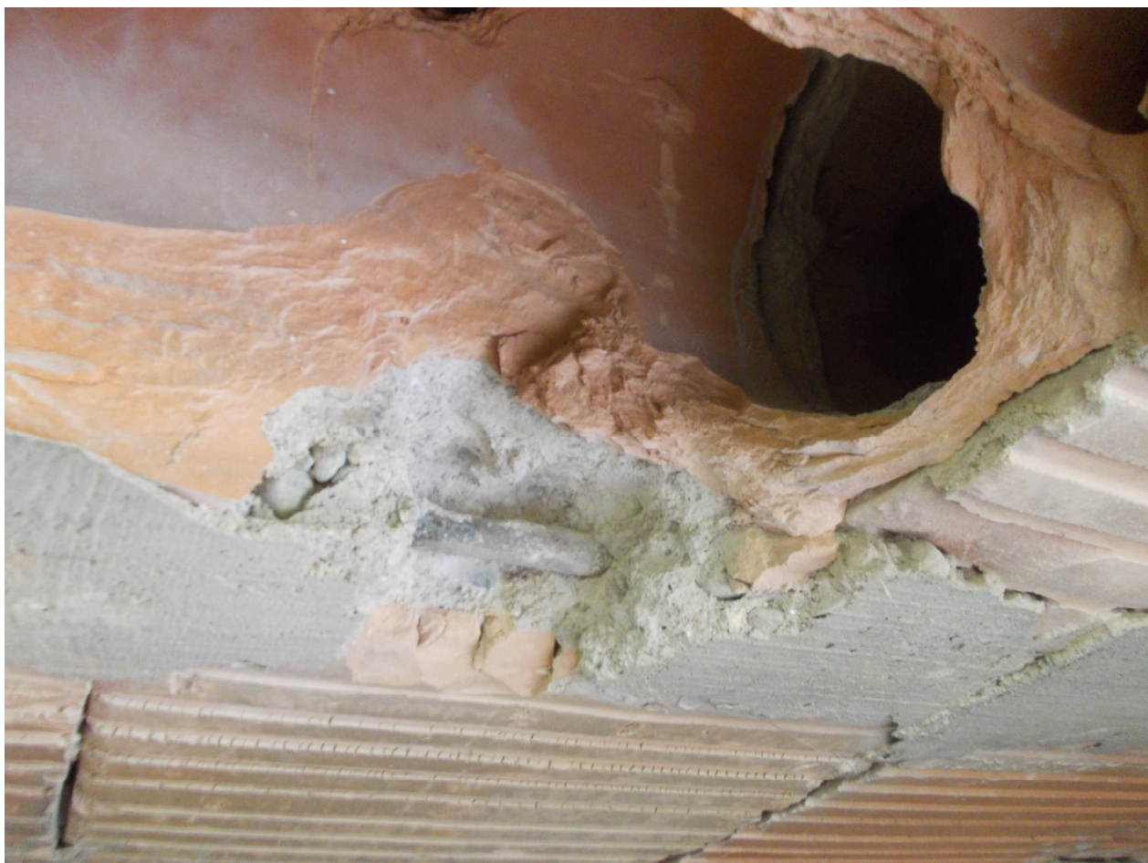
sondaggio 19 - solaio in laterocemento
