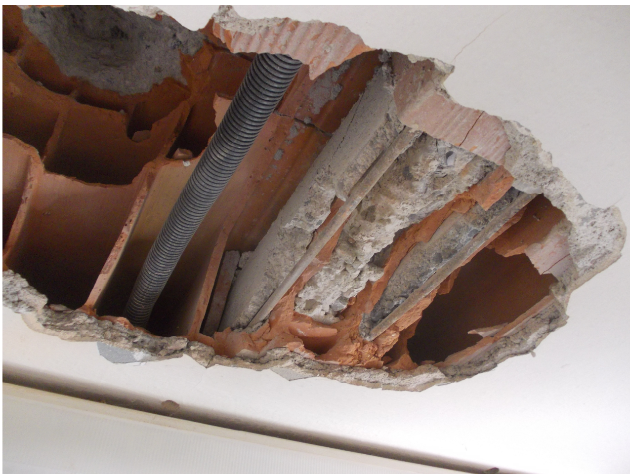
sondaggio 8 - solaio in laterocemento a travetti prefabbricati
