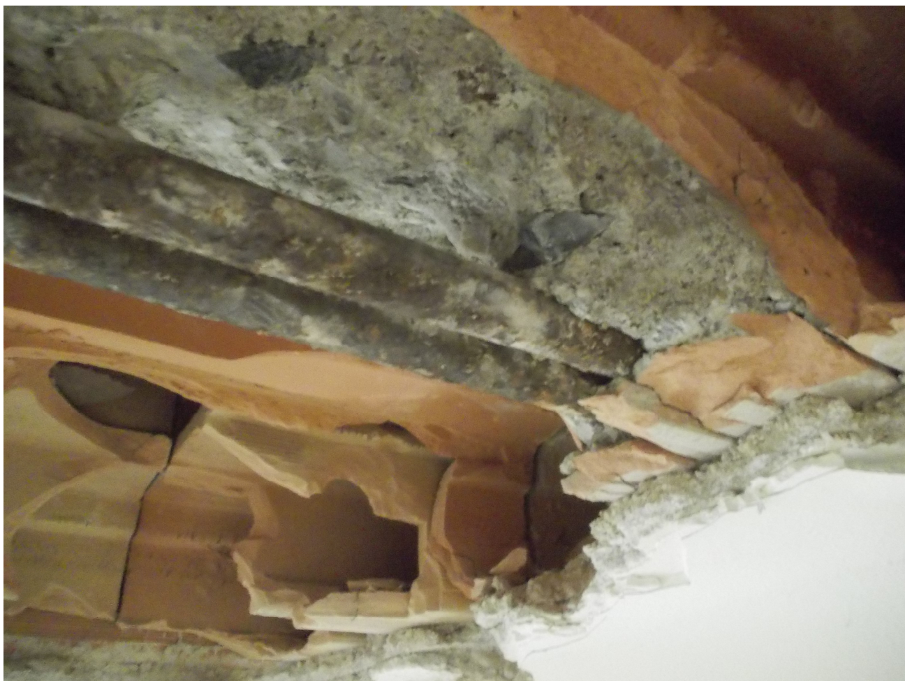
sondaggio 2 - solaio in laterocemento
