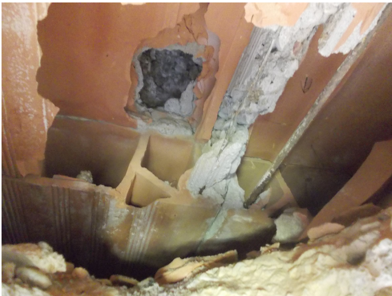
sondaggio 9 - solaio in laterocemento con pignatte preassemblate a piè d'opera
