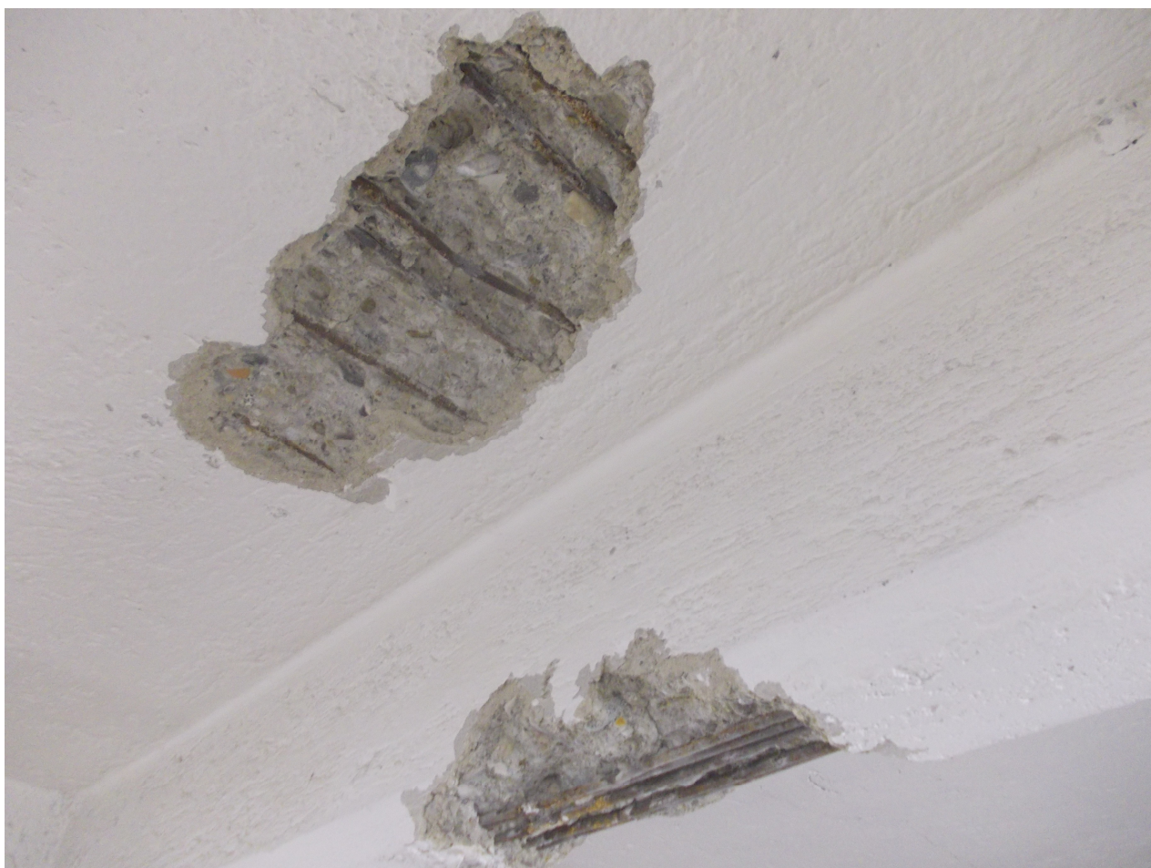
sondaggio 13 – trave secondaria e soletta in c.a.
