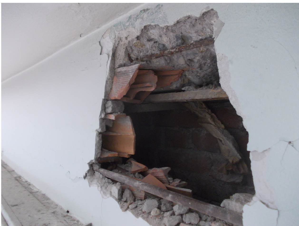
sondaggio 15 – trave di bordo e architrave finestra
