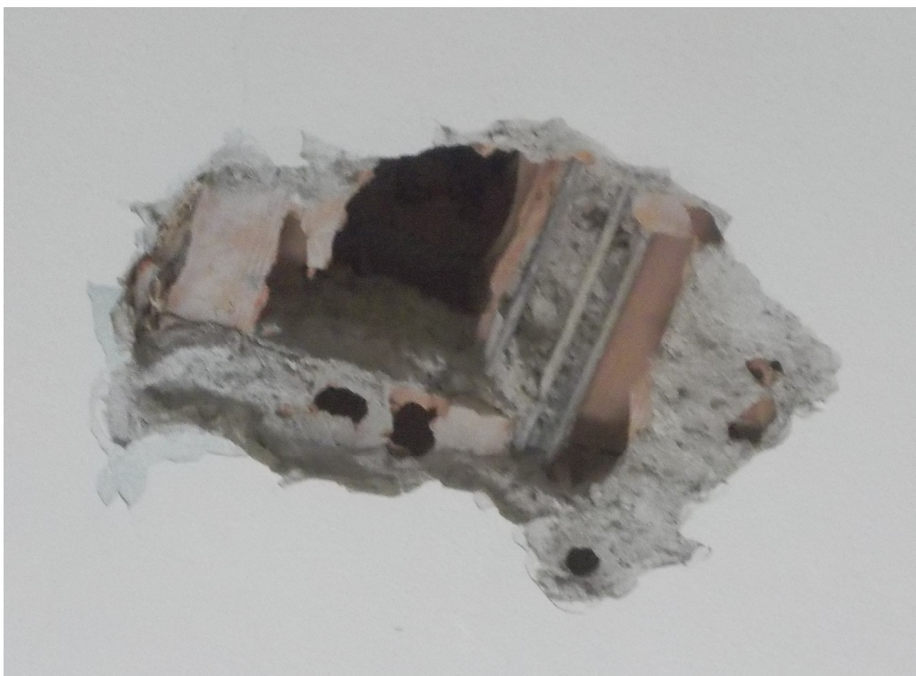
sondaggio 5 - solaio in laterocemento
