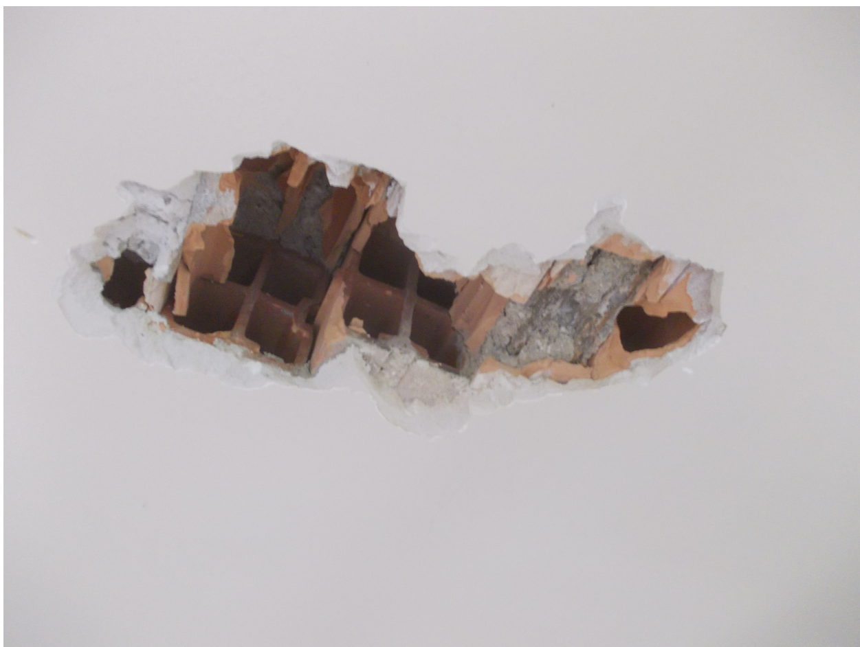
sondaggio 17 - solaio in laterocemento (come sondaggi 1-2-3)
