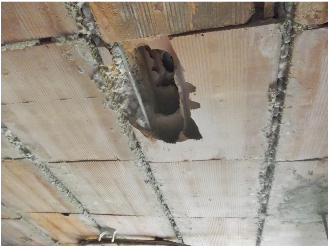
sondaggio 21 - solaio in laterocemento con pignatte preassemblate a piè d'opera
