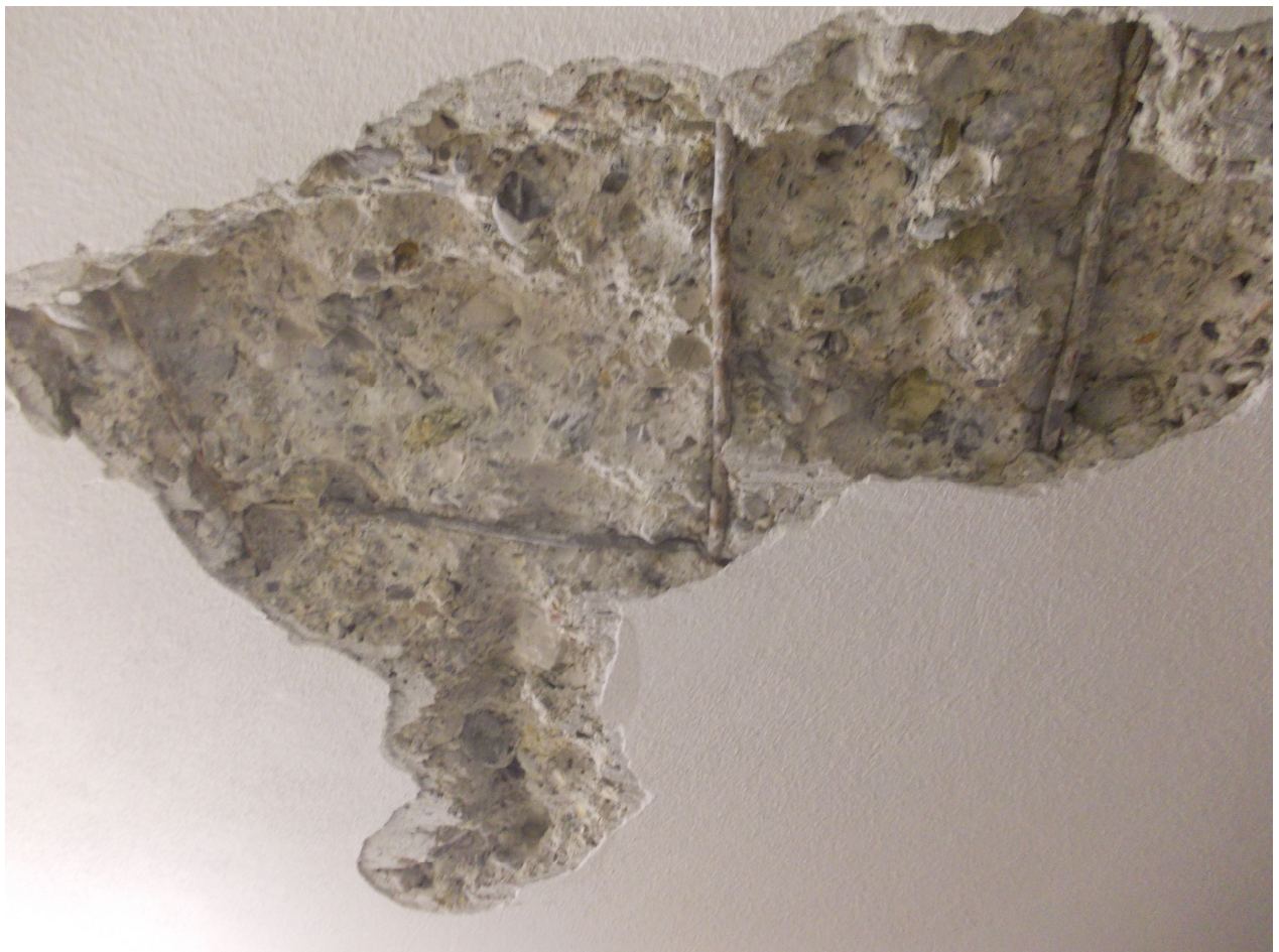
sondaggio 14 – soletta in c.a.
