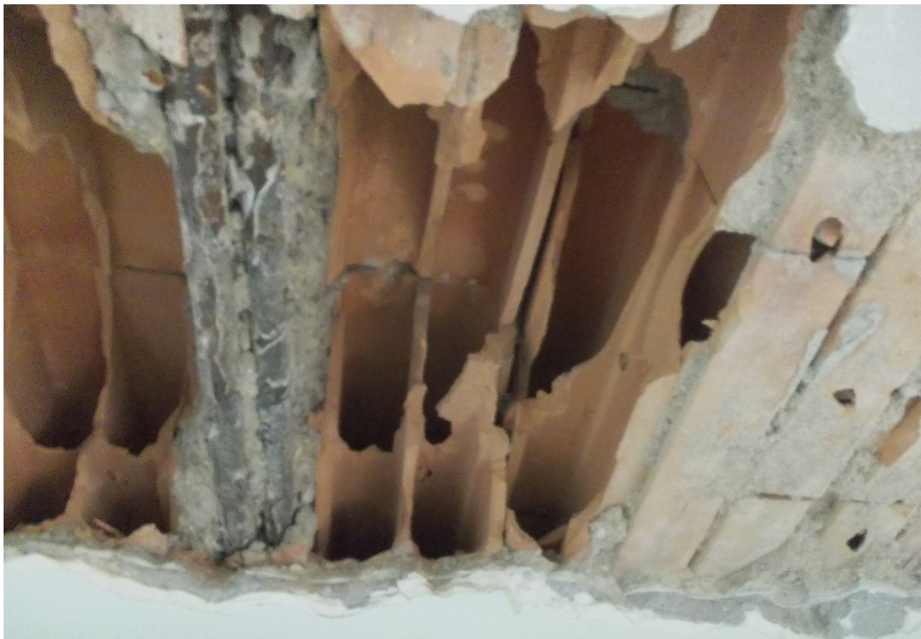
sondaggio 1 - solaio in laterocemento
