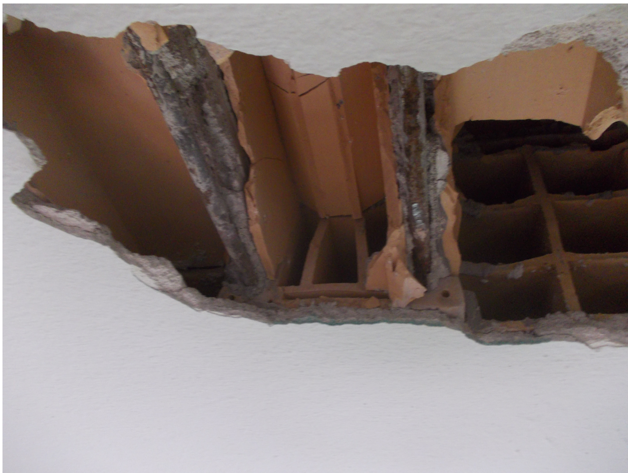
sondaggio 15 - solaio in laterocemento con travetti prefabbricati
