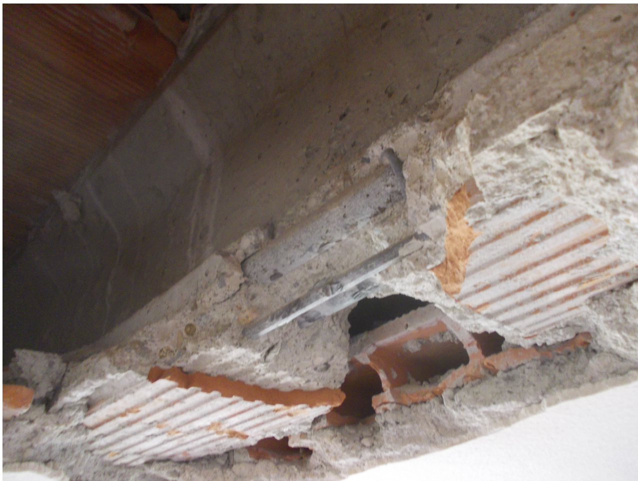
sondaggio 7 - solaio tipo Varese
