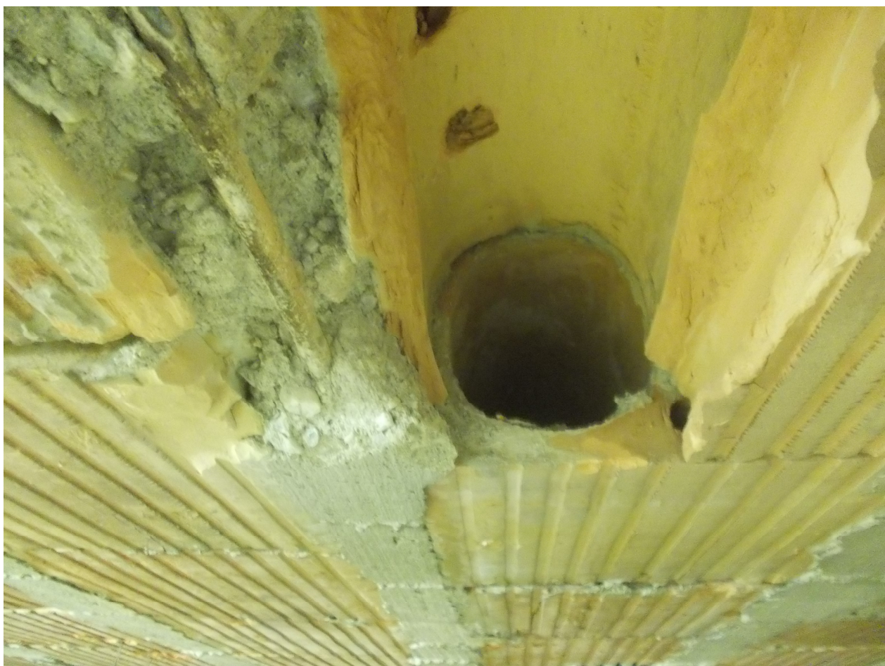
sondaggio 20 - solaio in laterocemento (come 19)
