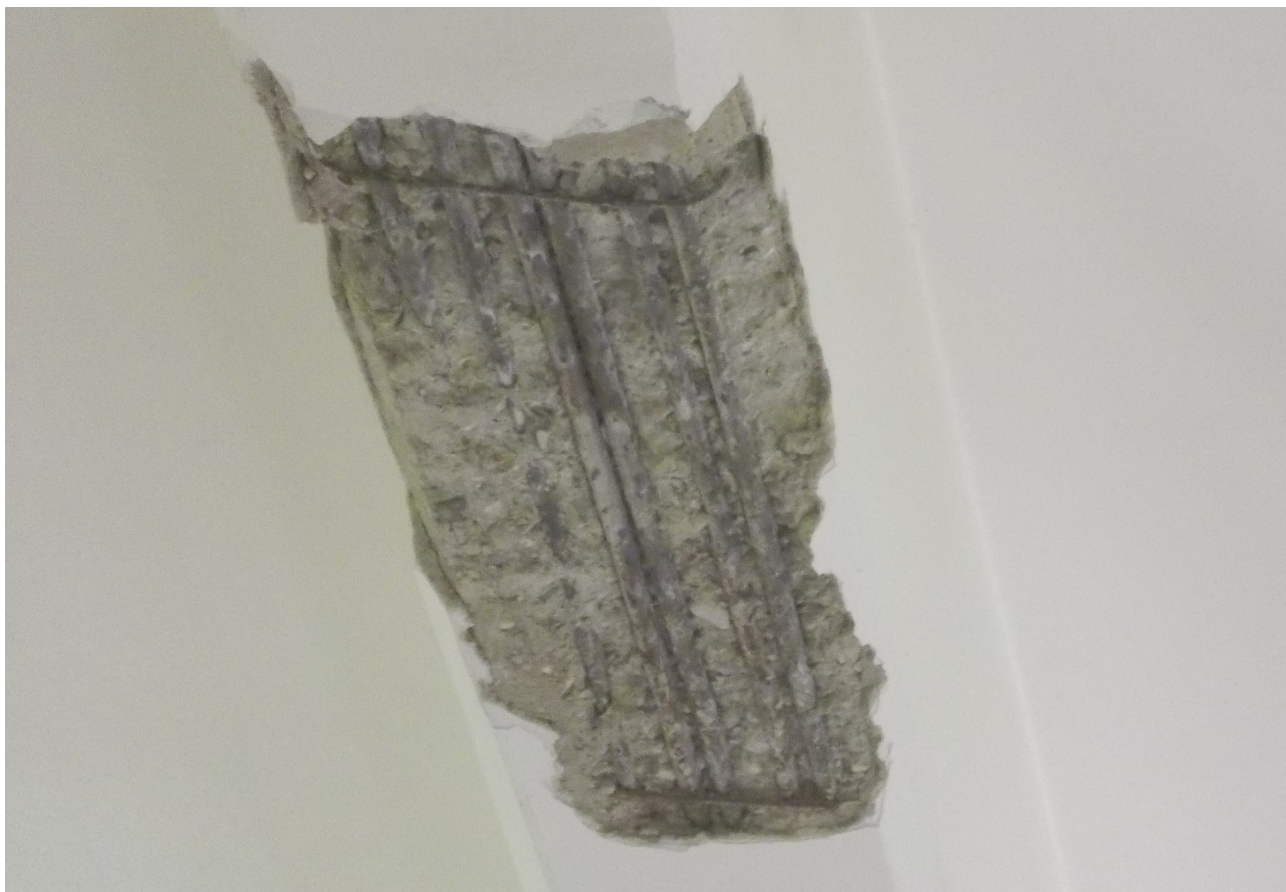
sondaggio 5 - trave in c.a.
