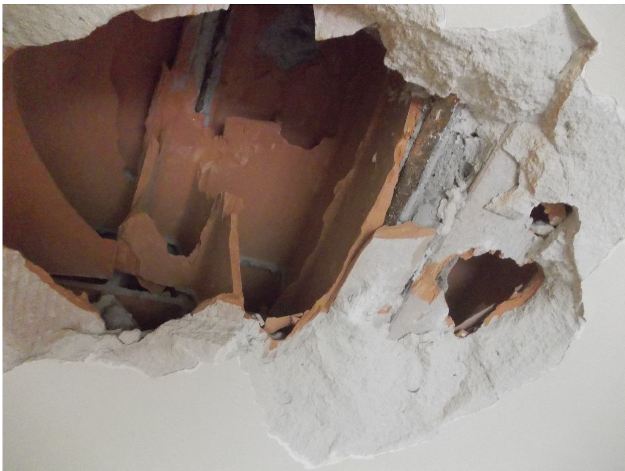
sondaggio 16 - solaio in laterocemento
