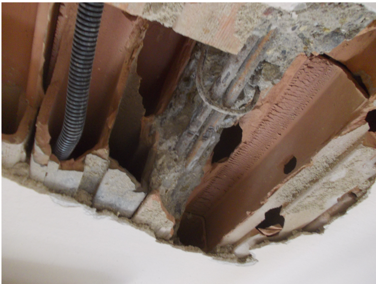
sondaggio 3 - solaio in laterocemento
