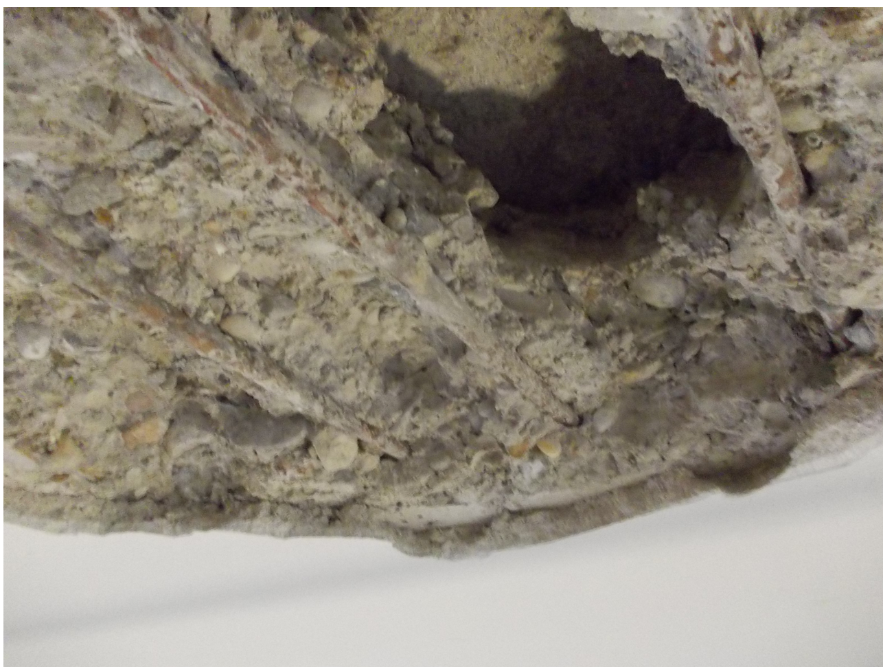
sondaggio 4 - solaio in c.a.
