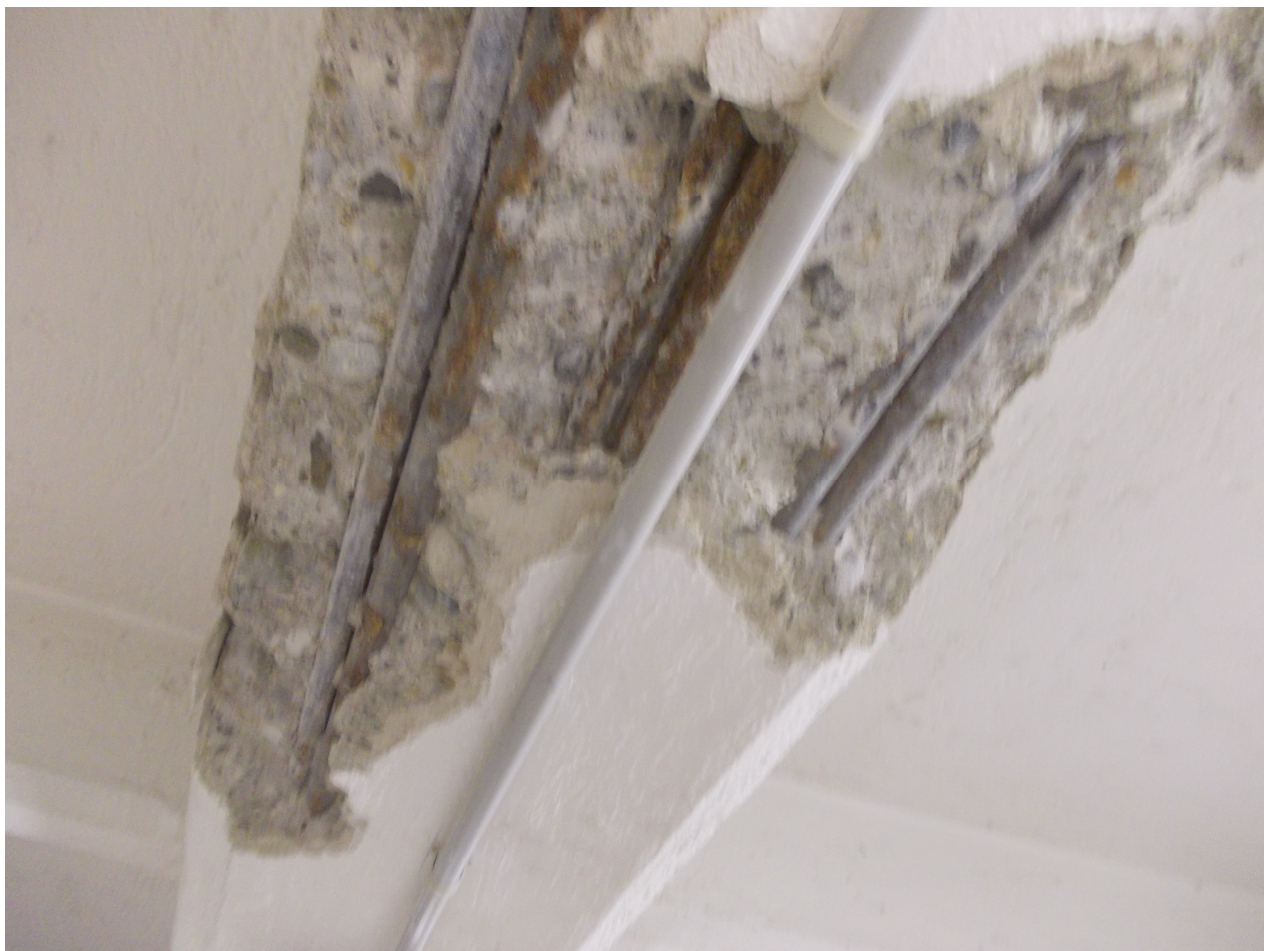
sondaggio 13 – trave principale in c.a.
